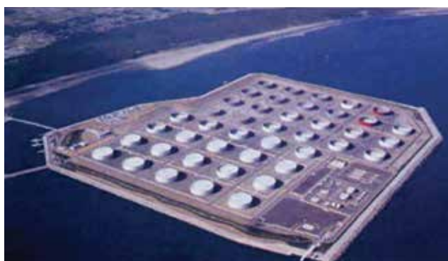
Hình 4. Kho chứa dầu trên mặt biển tại Shirashima (Nhật Bản) [6]
